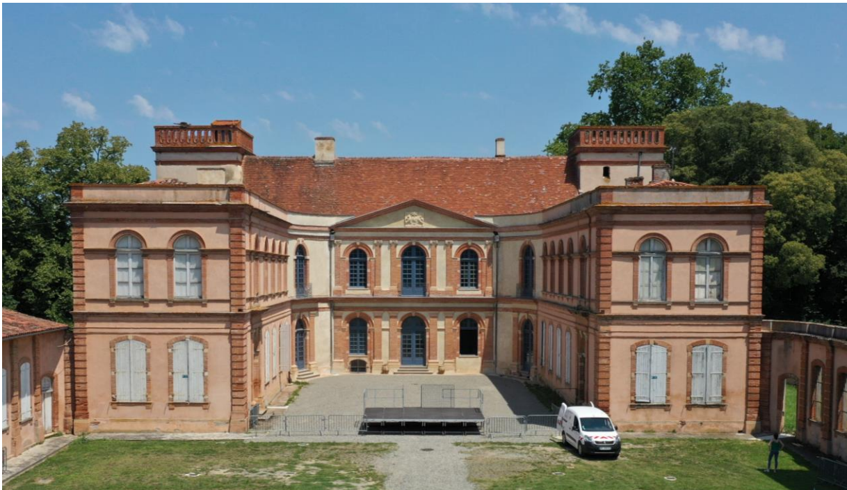
Fig.10 – VUE DE LA FACADE PRINCIPALE SUD – BATIMENT 1, CORPS DE LOGIS
