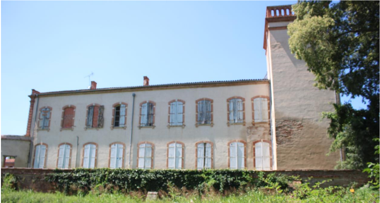
Fig.12 – VUE DE LA FACADE EST – BATIMENT 1, CORPS DE LOGIS
