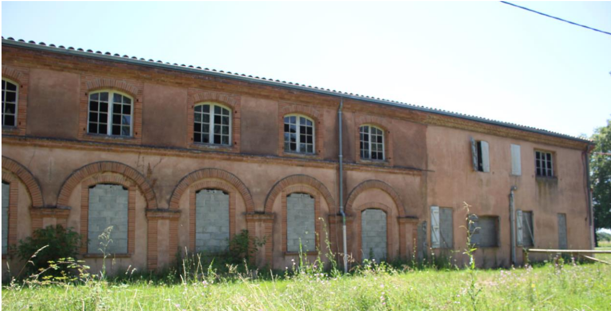
Fig.15 – VUE DE LA FACADE OUEST – BATIMENT 2, ENSEMBLE GARONNE
