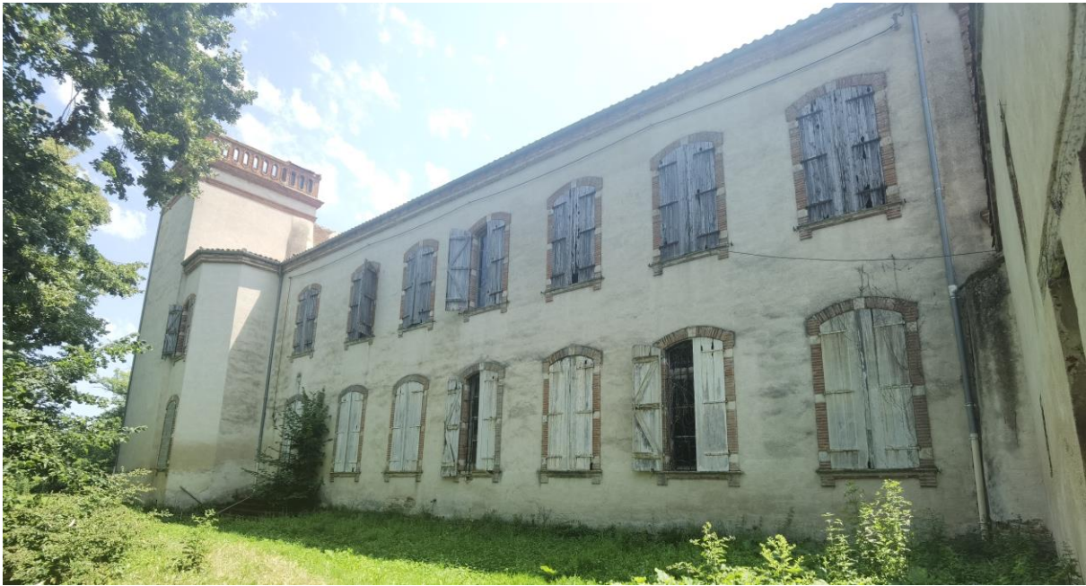
Fig.13 – VUE DE LA FACADE OUEST – BATIMENT 1, CORPS DE LOGIS
