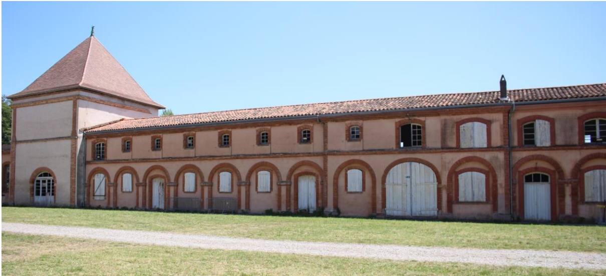
Fig.17 – VUE DE LA FACADE OUEST – BATIMENT 3, ENSEMBLE ARIEGE
