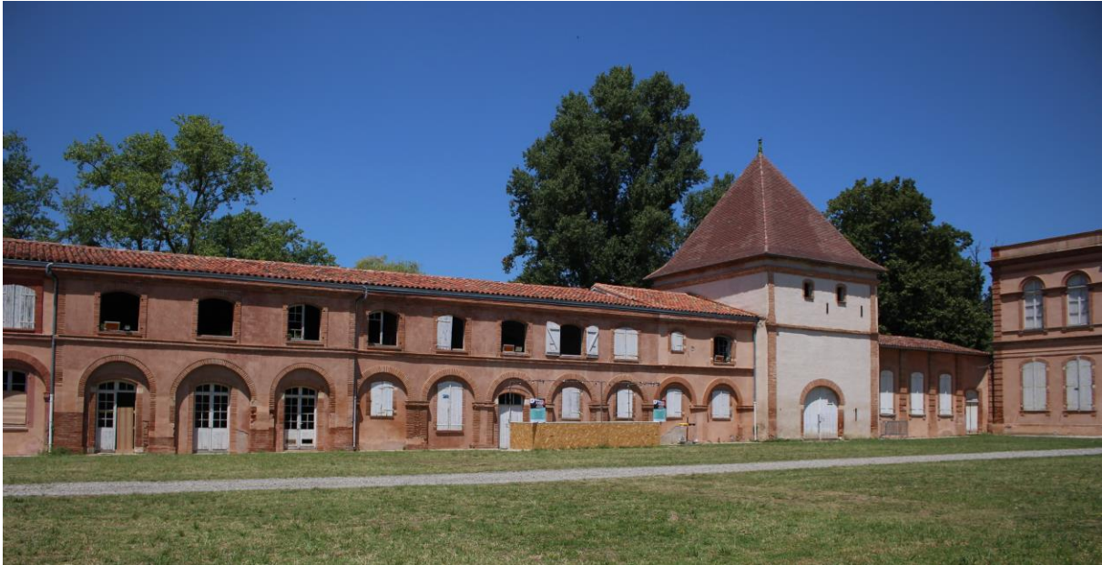
Fig.14 – VUE DE LA FACADE EST – BATIMENT 2, ENSEMBLE GARONNE
